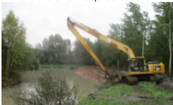
Figure 8 : Illustration d'une pelle utilisée lors de travaux de désenvasement (ici depuis la berge)
